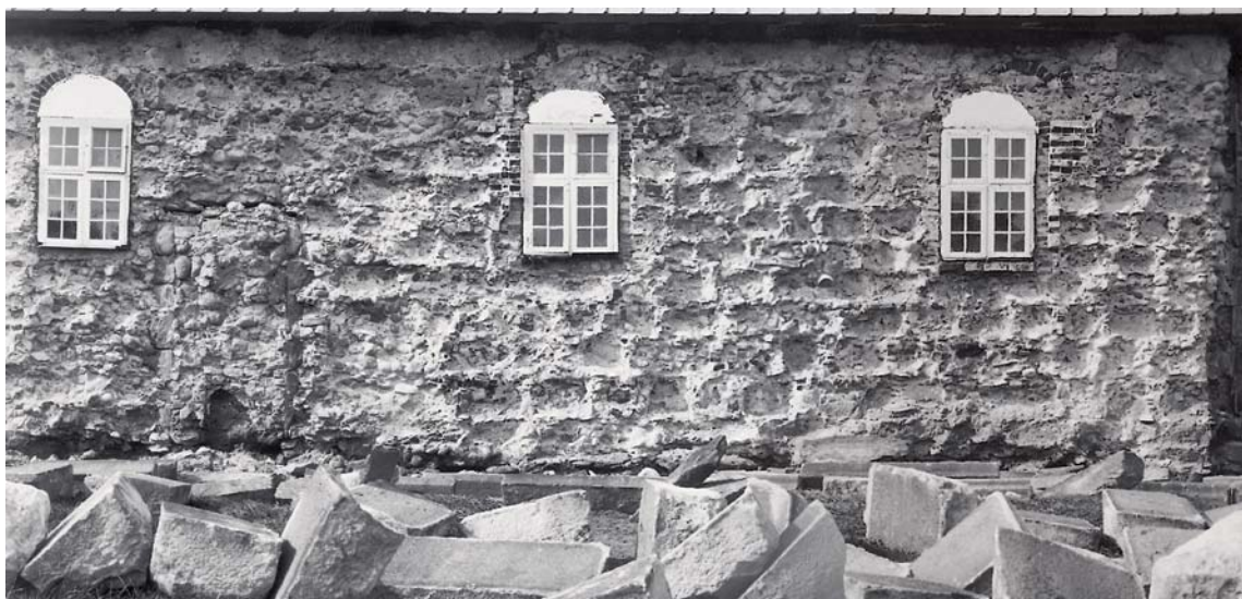
Fig. 9. Udsnit af skibets sydfacade under restaurering med spor af tilmuret dør og ældre vinduesåbninger (s. 1102). Foto Sven Fritz 1941-42, fotomontage af tre optagelser ved MV 2010. – Ausschnitt der Südseite des Schiffes während der Restaurierung mit Spuren einer zugemauerten Tür und älteren Fensteröffnungen.
