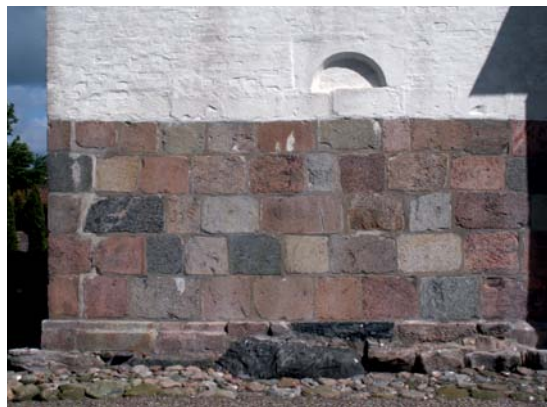
Fig. 15. Udsnit af tårnets sydfacade med genanvendte romanske granitkvadre og vinduesoverligger (s. 1094), Foto Hugo Johannsen 2009. – Ausschnitt der Südfassade des Turmes mit wiederverwendeten romanischen Granitquadern und Fenstersturz.
