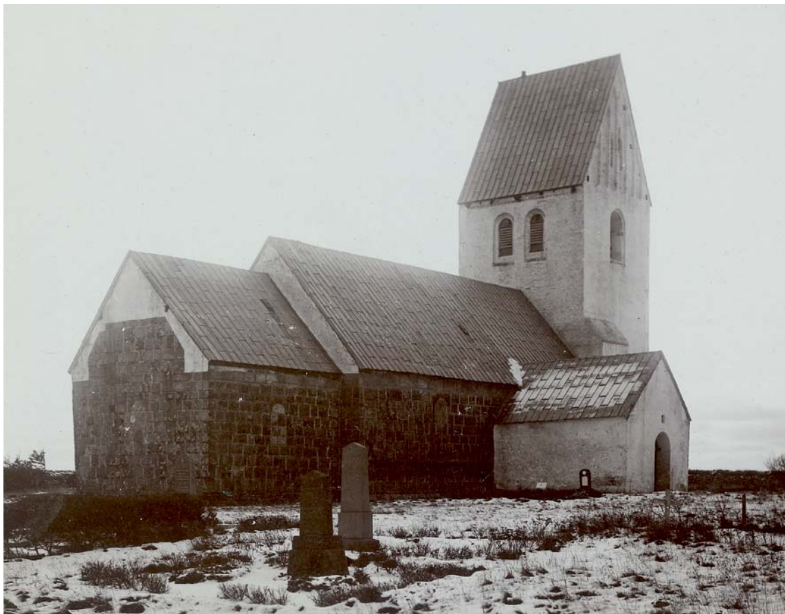
Fig. 17. Kirken set fra nordøst. Ældre foto (før 1917). – Kirche aus Nordosten .
